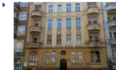
Miejsce: Zjednoczenia 5, 5a
