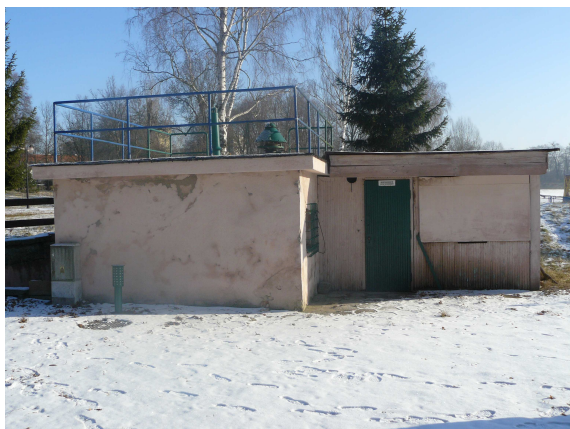
Budynek pompowni wody
