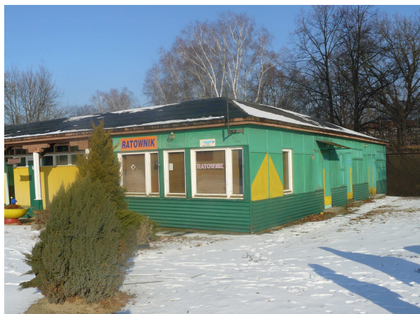
Budynek główny - Elewacja południowo-wschodnia
