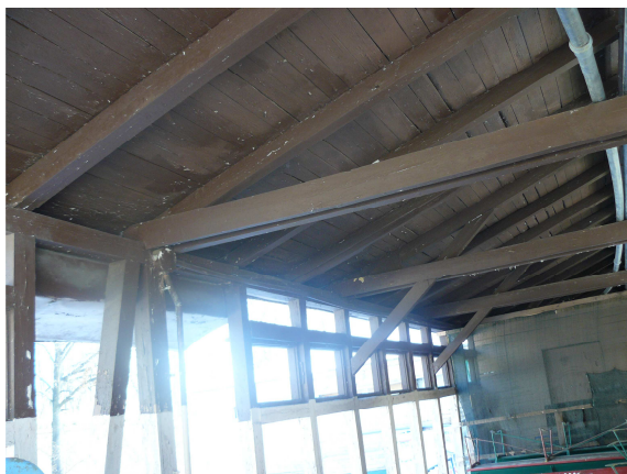
Budynek główny - Konstrukcja drewniana dachu
