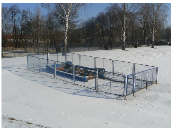
Miejsce zrzutu wody do zbiornika
