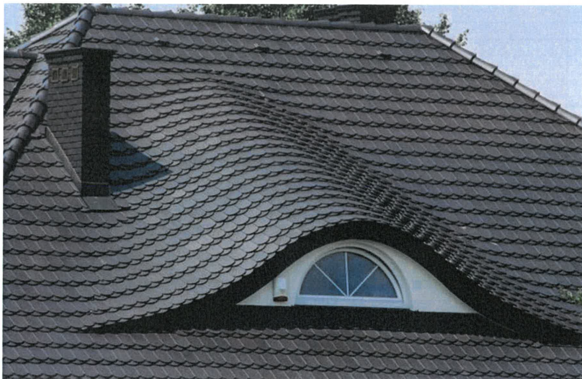
Ryc. 60 Przykład dachu ułożonego z karpiówki w koronkę.
