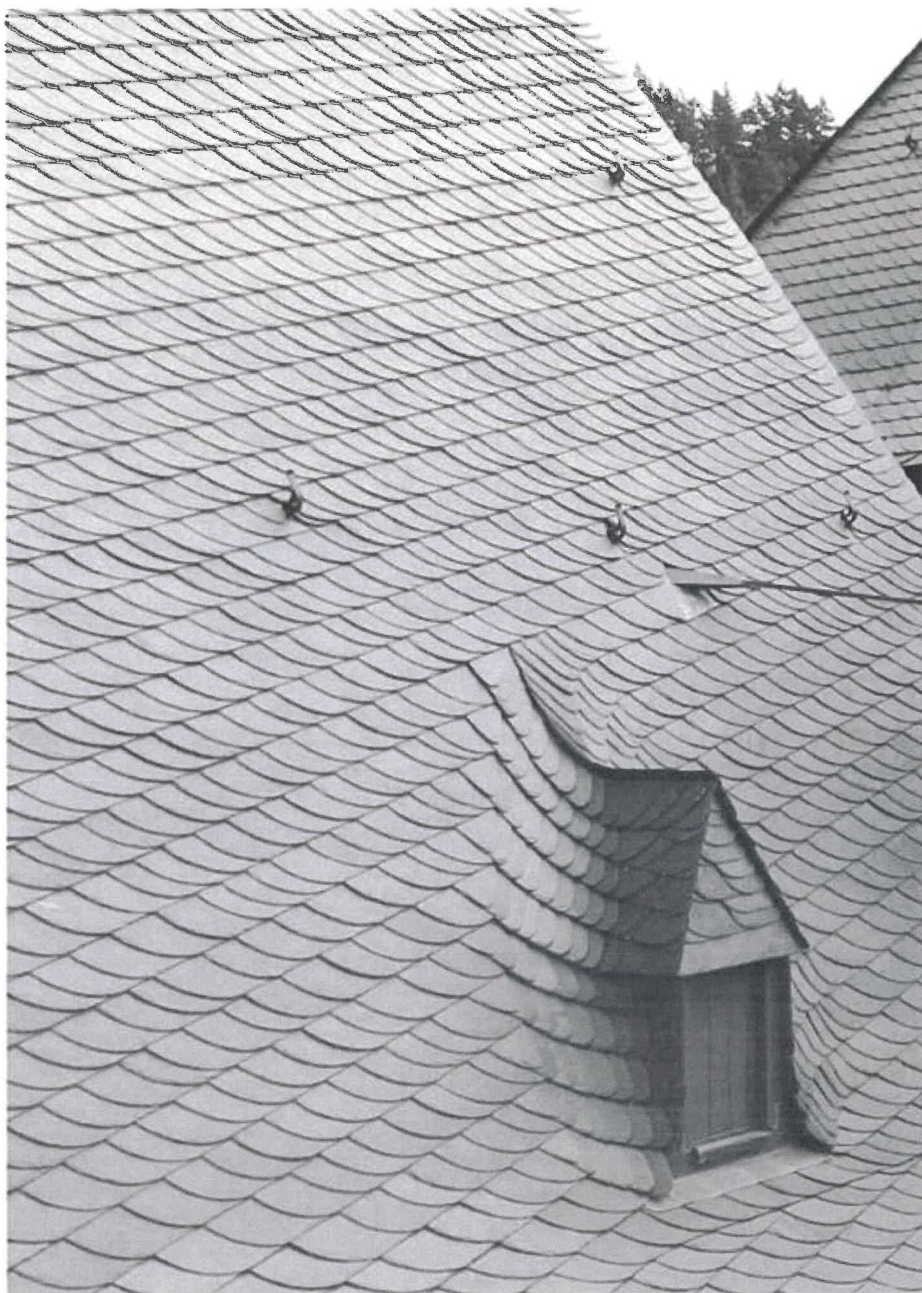
Ryc. 59 Przykład krycia dachu stylem staroniemieckim
