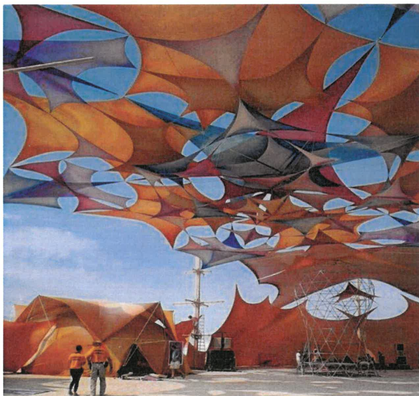
Ryc. 50 Przykład zacienienia nasłonecznionych przestrzeni zadaszeniami w formie żagli, w celu zmniejszenia ich temperatury powierzchniowej. Malaga przed świętem "Fiesta de Malaga", Hiszpania - źródło: foto własne
